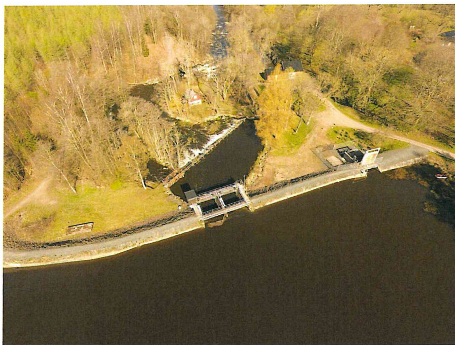
Figur 3. Nedströmsvy över anläggningen. Foto: Rejlers.
