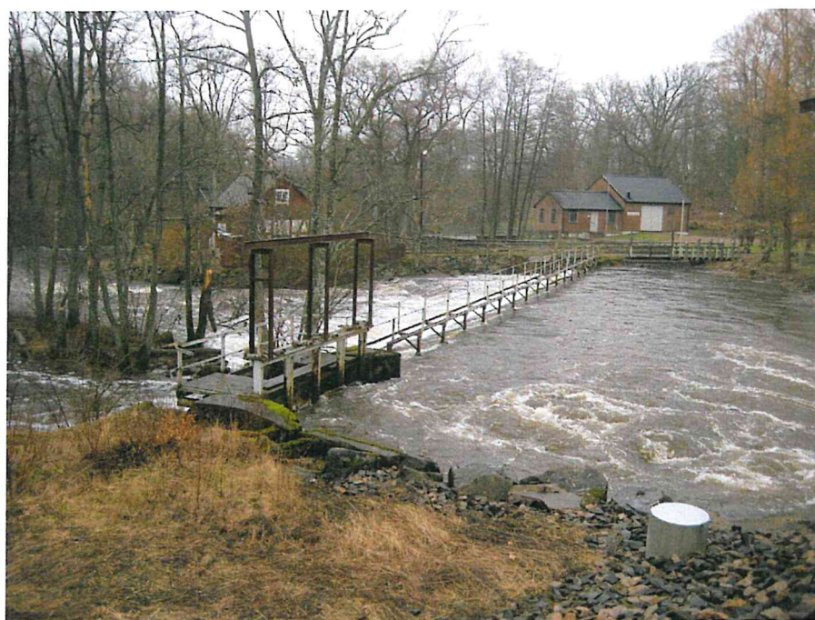
Figur 9. Damm direkt nedströms flodutskov med skibordsöverfall från äldre anläggning. Äldre intag syns till höger om skibordet.
