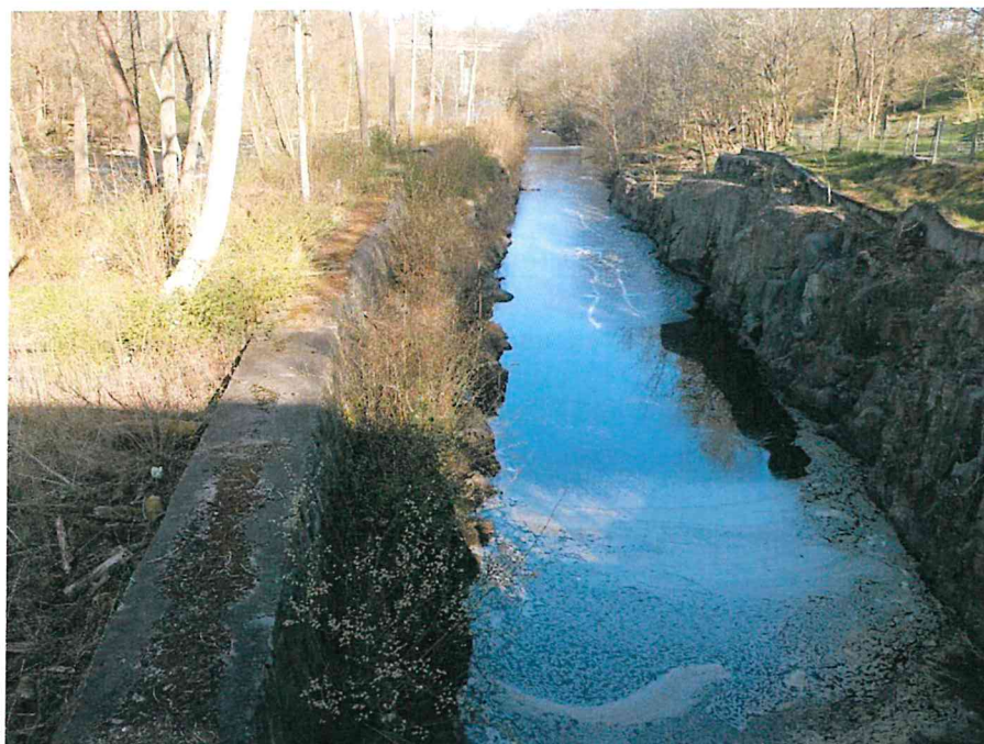
Figur 11. Nedströmsvy över utloppskanalen från kraftstationen.
