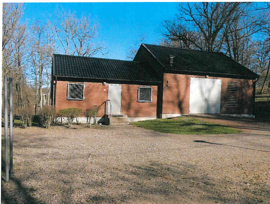
Figur 8. Nedströmsvy över kraftstationen.
